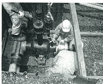
KN分岐工法の施工現場
